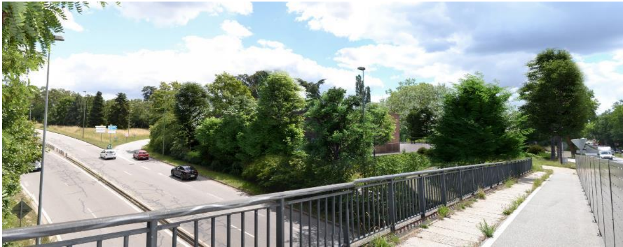
Figure 15 : Insertion paysagère du projet sur la boucle est depuis la D 186 (depuis le nord)
