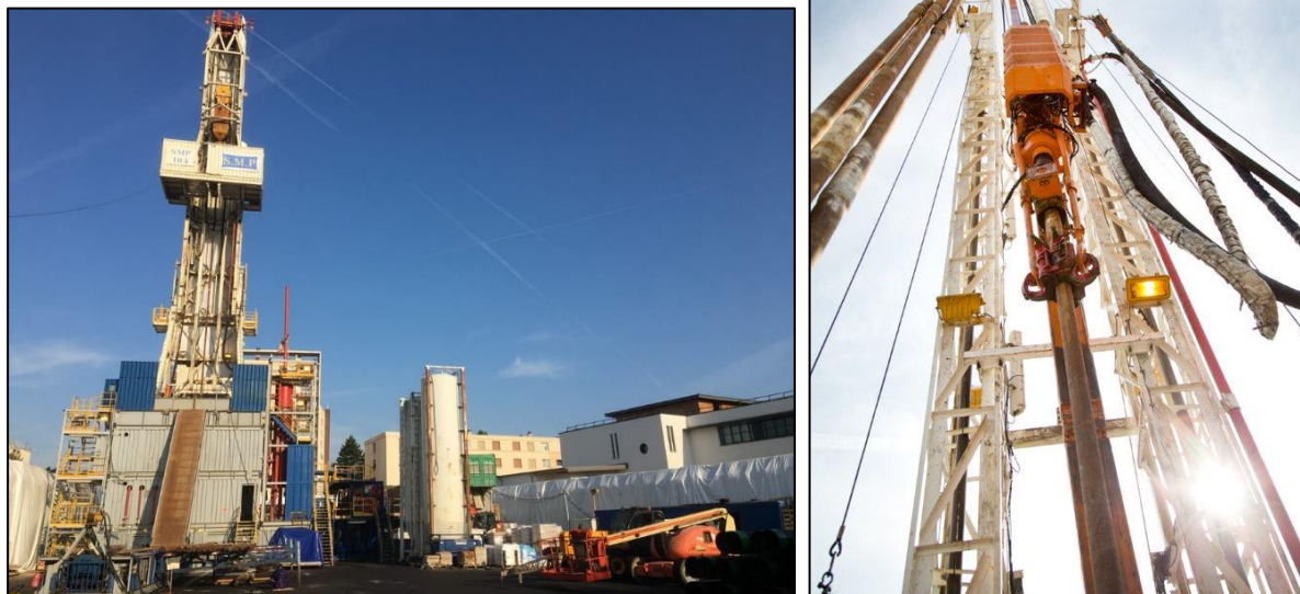
Figure 6 : Exemples d'ateliers de forages géothermiques (Source : ENGIE Solutions)
